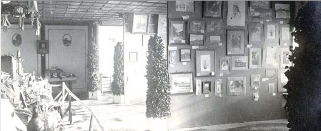
Blick in einen der Ausstellungsräume bei der „Ausstellung für Bildkunst und Handfertigkeit“ im März 1918
